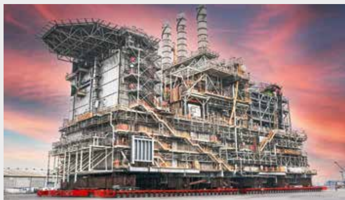
Weltrekord aus dem Jahr 2004: Transport einer 14.350 t schweren Öl- und Gasplattform.
