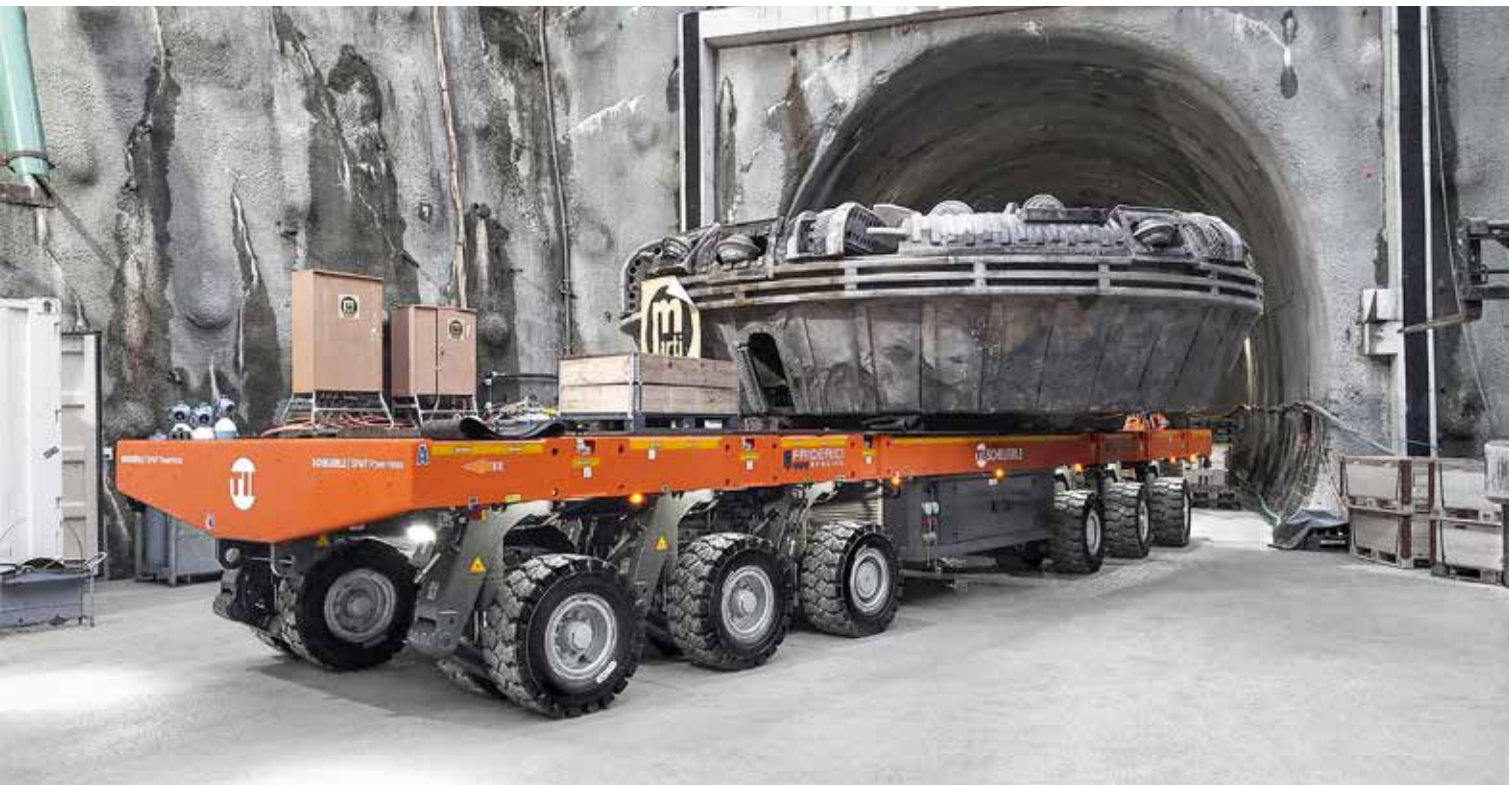
Weitere Herausforderungen folgten beim Transport von Tunnelbohrmaschinenteilen, die auf engstem Raum manövriert werden mussten.
