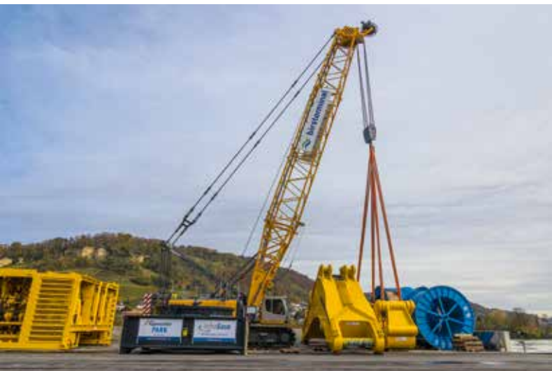
Die Baggerteile des Komatsu PC8000 sind im Bisterminal angekommen.
