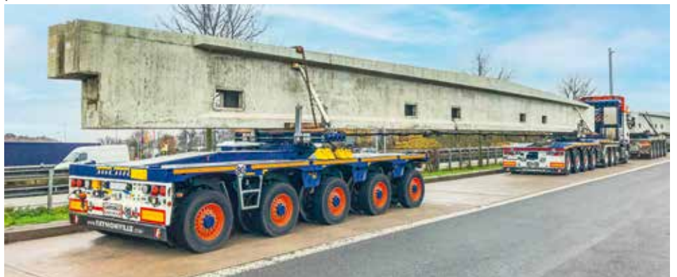
Montageort, setzen Experten auf Cometto SPMT Selbstfahrer, die für solche XXL-Aufgaben die nötige Technologie aufweisen.
