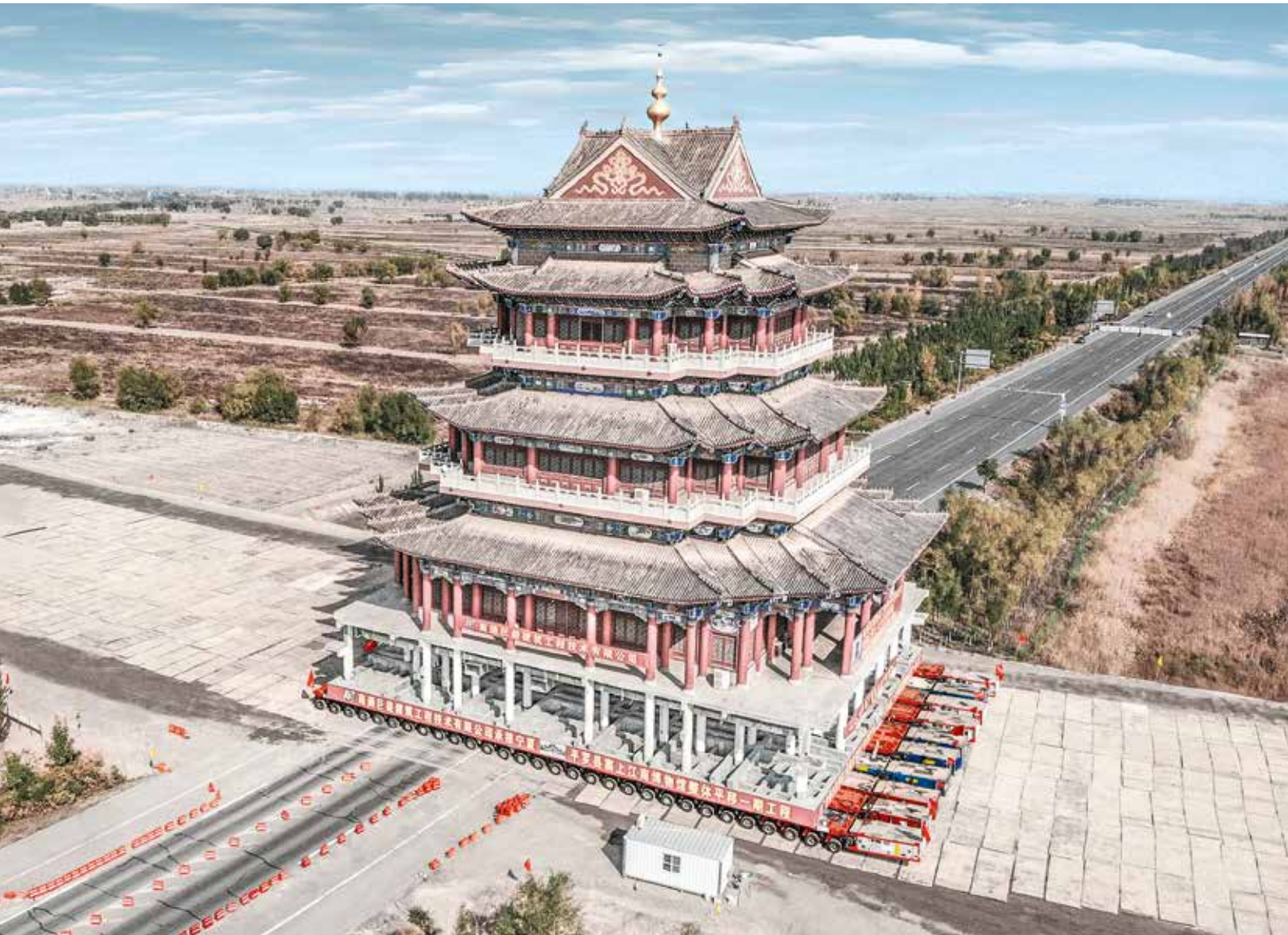
Beim Transport musste auch eine Straße gequert werden.
