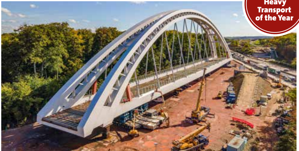
Die insgesamt 180 Achslinien der Cometto-SPMTs sind unter Brücke platziert.
