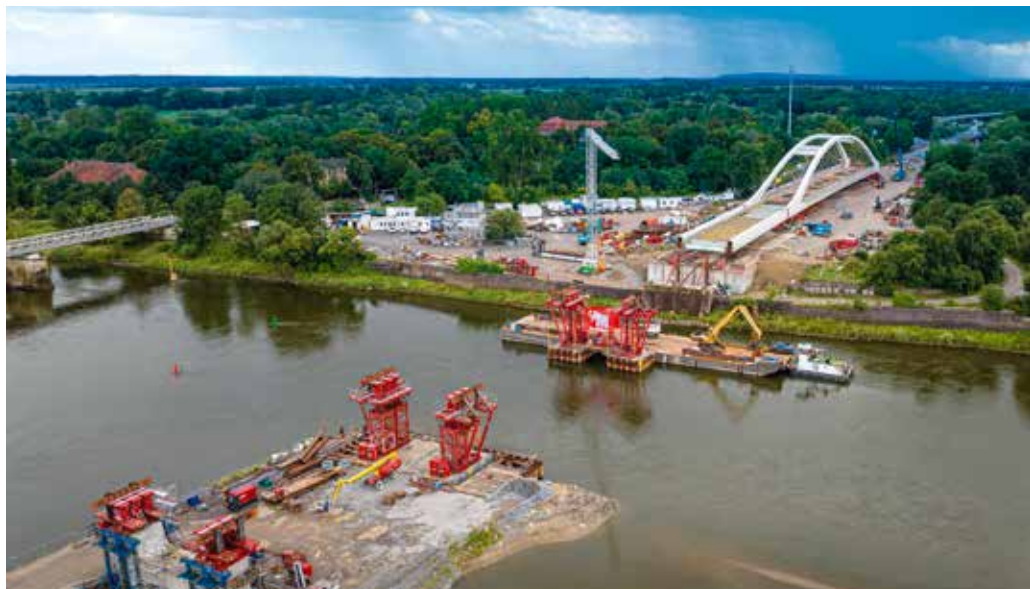
Die Brücke wurde auf der deutschen Seite der Oder montiert und als Gesamtkonstruktion bewegt.
