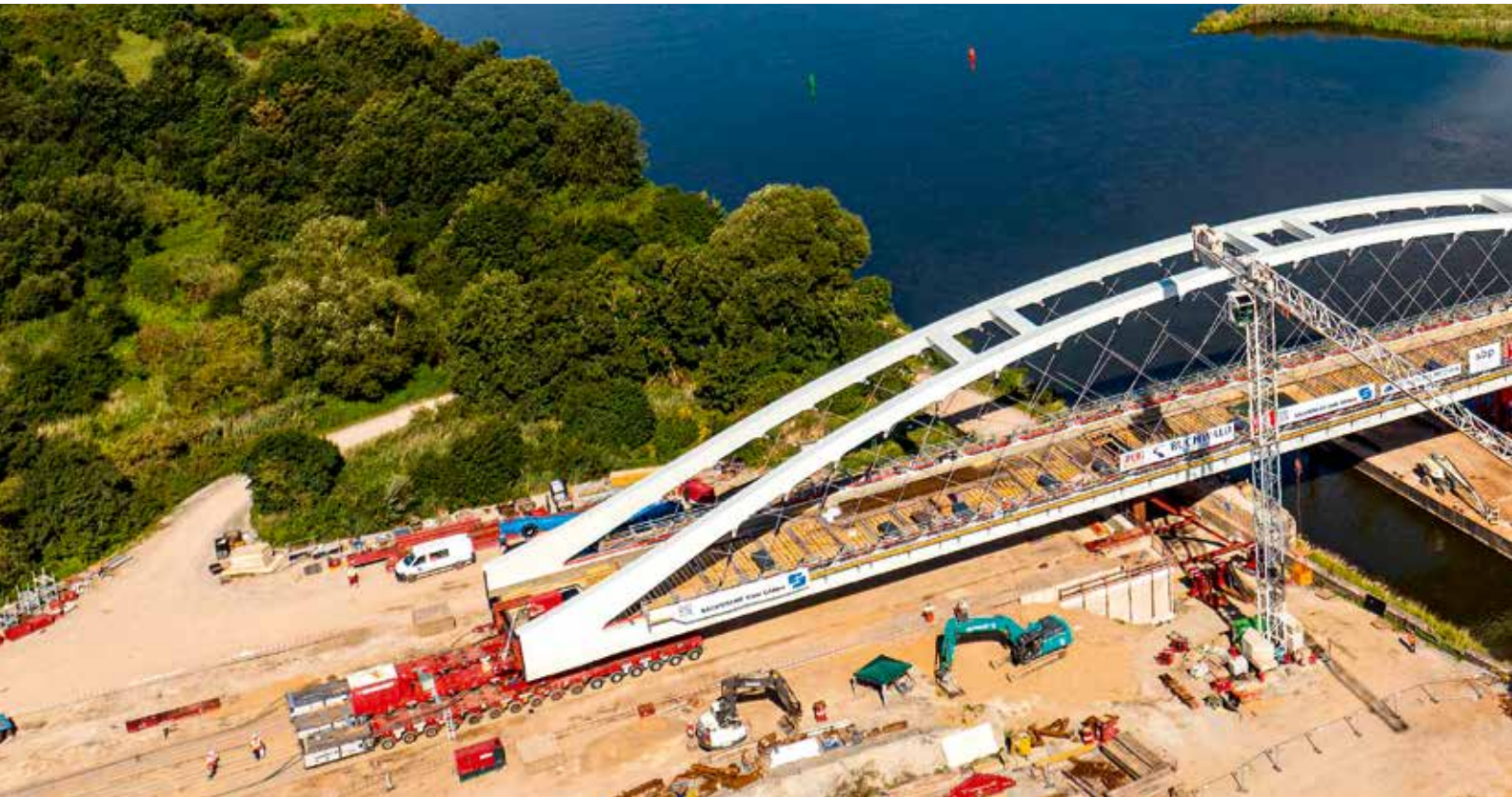
Die Netzwerkbogenbrücke erreicht das polnische Flussufer. Das linke Brückende war dabei noch auf den SPMT-Einheiten gelagert.
