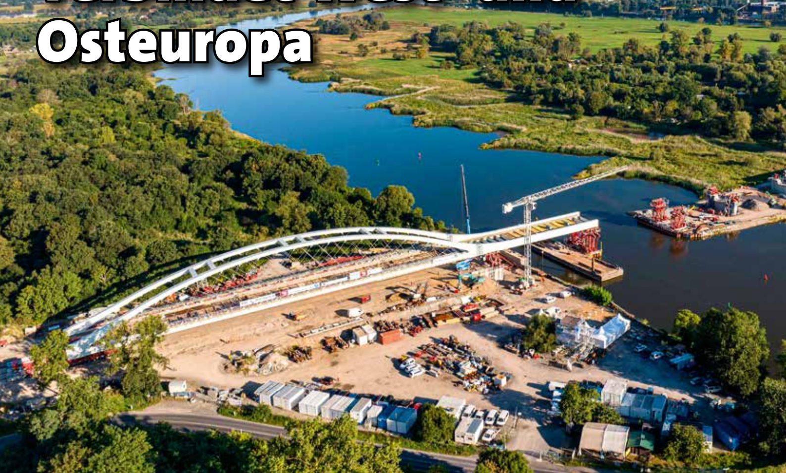
Innovative Netzwerkbogenbrücke mit Carbon-Hängern.
