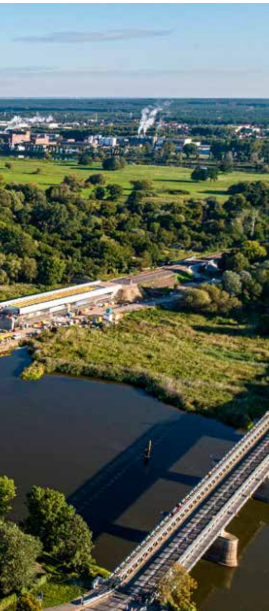
Die Brücke wurde auf der deutschen Seite der Oder montiert und als Gesamtkonstruktion bewegt.
