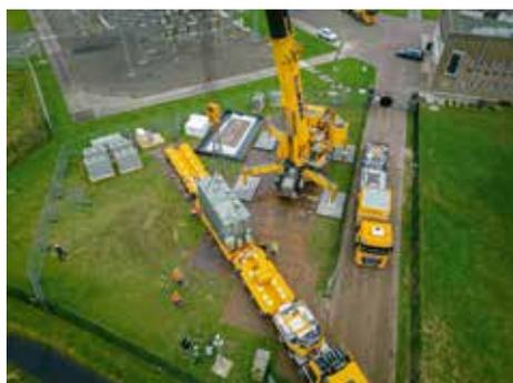
Direkt nachdem der Trafo vom Transportfahrzeug gehoben wurde, nimmt das Tiefbett wieder seine bogenförmige Vorspann-Position ein.
