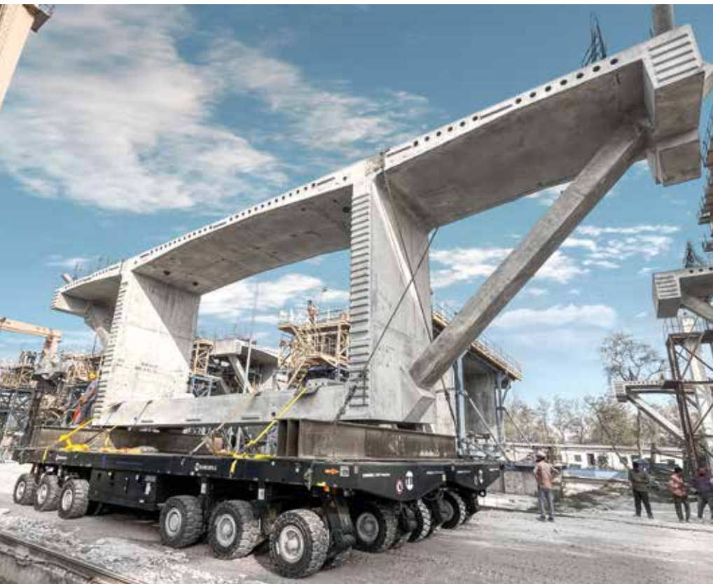
Seitlich gekuppelt befördern 2 PowerHoss Module 175 t schwere Brückensegmente bis zum Trägerwerfer.
