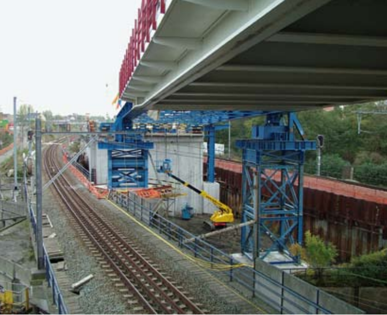
Die (blauen) Stahlsäulen stützen die Brücke während der Bewegung.
