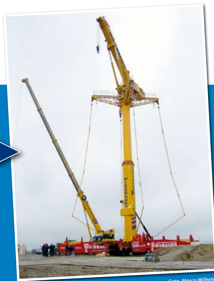
Der Vertikalmast wird auf 81 m austeleskopiert.
