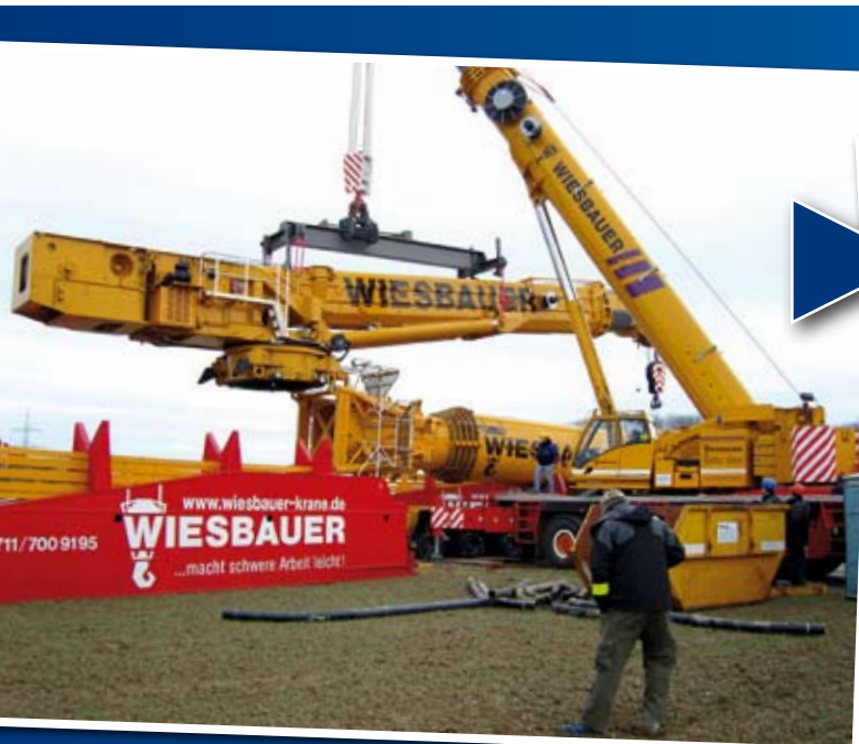
Montage des Oberwagens am Vertikalturm. Foto: Marco Wilhelm
