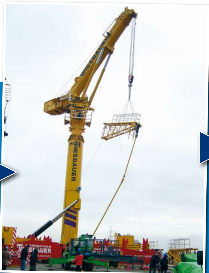
Anbringen der Spreader in Selbstmontage.
