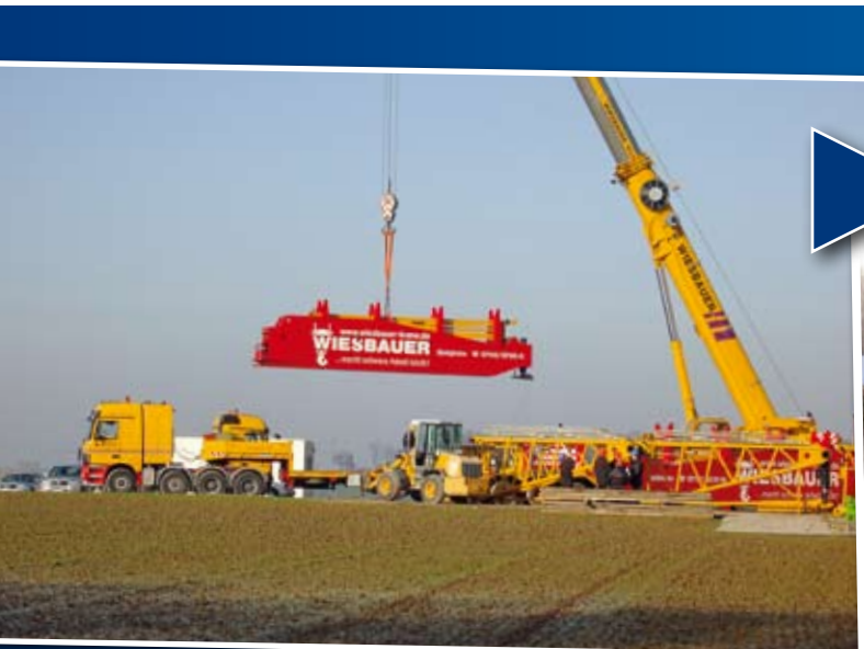
Per Hilfskran (GMK 5220) werden die Stützen angebaut.
