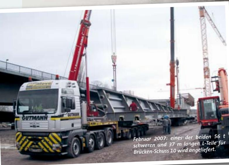
Februar 2007: eines der beiden 56 t schweren und 37 m langen L-Teile für Brücken-Schuss 10 wird angeliefert.
