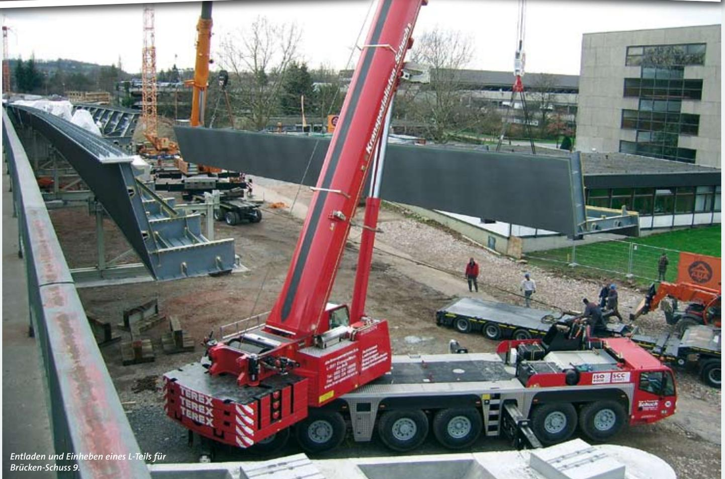
Entladen und Einheben eines L-Teils für Brücken-Schuss 9.
