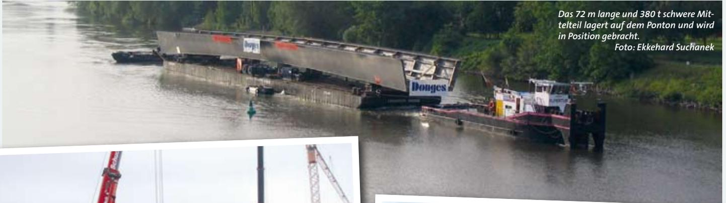
Das 72 m lange und 380 t schwere Mittelteil lagert auf dem Ponton und wird in Position gebracht.
