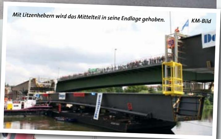
Mit Litzenhebern wird das Mittelteil in seine Endlage gehoben.
