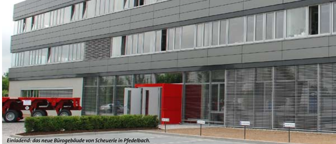
Einladend: das neue Bürogebäude von Scheuerle in Pfedelbach.
