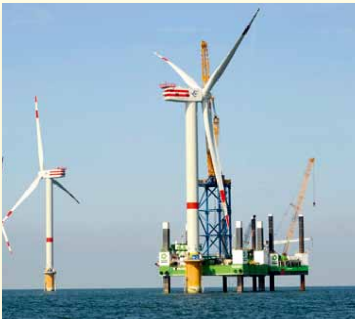
Für die Durchführung des Projekts Thornton Bank in Ostende, bei dem Sarens eine 750 t-Raupe, auf einem 40 m hohen Multi Lift Tower einsetzte, gewann Sarens den ESTA-Award 2009. Foto: Jan Oelke
