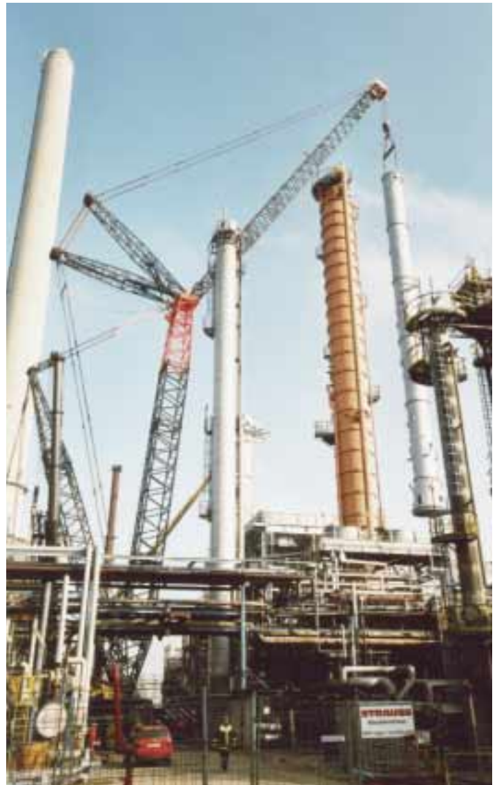
Der LGD 1550 des Betreibers Thömen hebt die Kolonne über eine bestehende Anlage. Benötigte Ausladung: 36 m Foto: R. Bublitz
