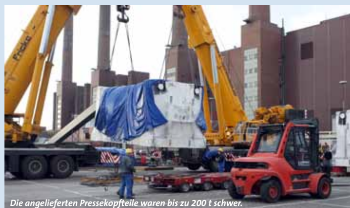
Die angelieferten Pressenkopfteile waren bis zu 200 t schwer.
