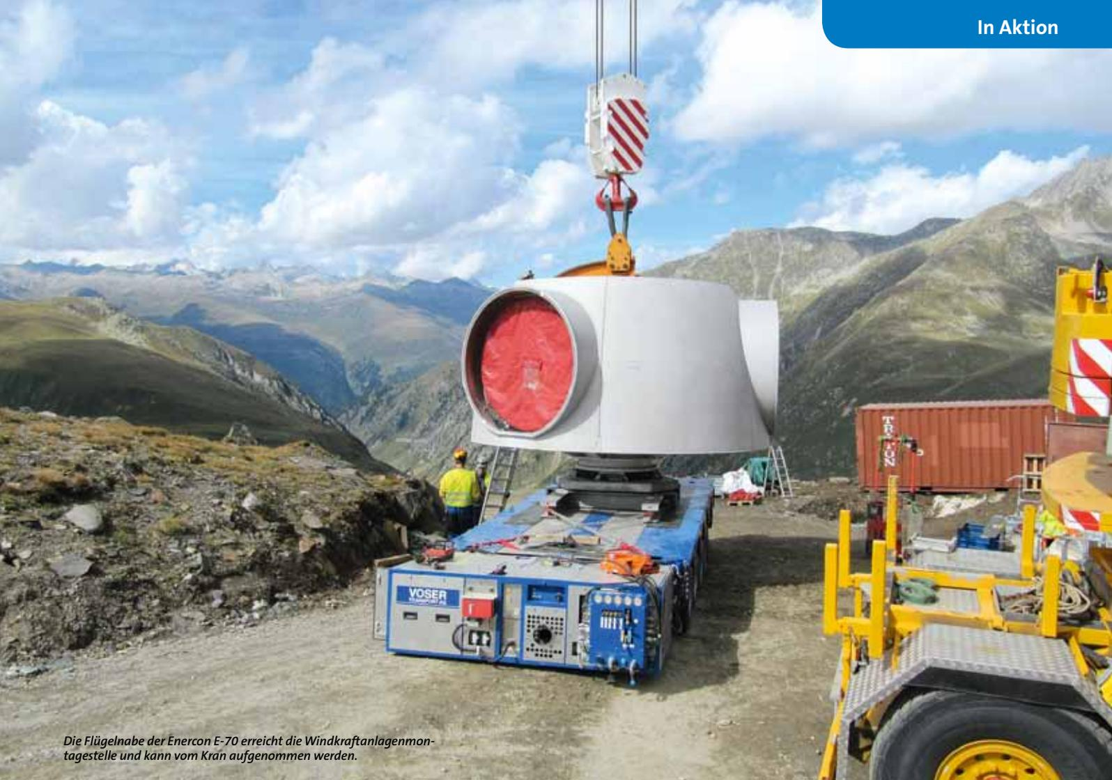
Die Flügelnahe der Enercon E-70 erreicht die Windkraftanlagenmontagestelle und kann vom Kran aufgenommen werden.
