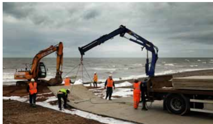
Traxpanels im Einsatz: hier im englischen Cellarfield.
