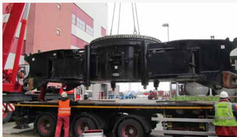
Transport eines Raupenträgers und des Unterwagens. ►
