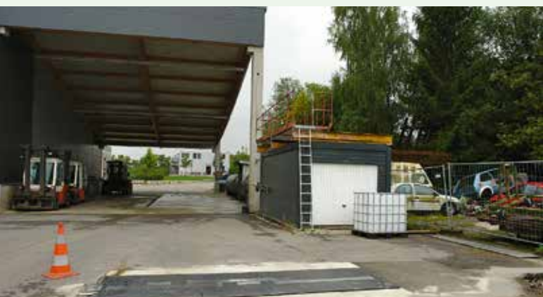
Prüfstraße: Vorne im Asphalt die Sensorrampe, hinten rechts an der 2. Säule das Display.
