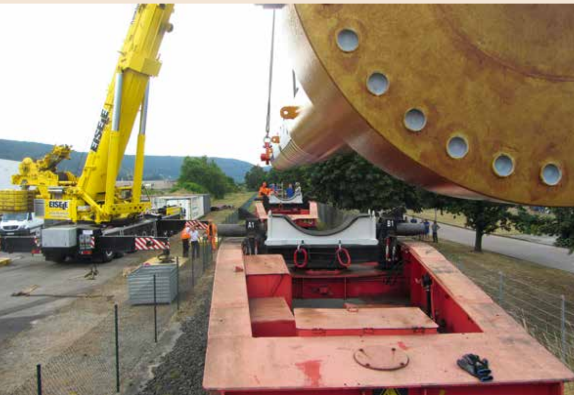
Der Zylinder wird auf die Lastträger gehoben.
