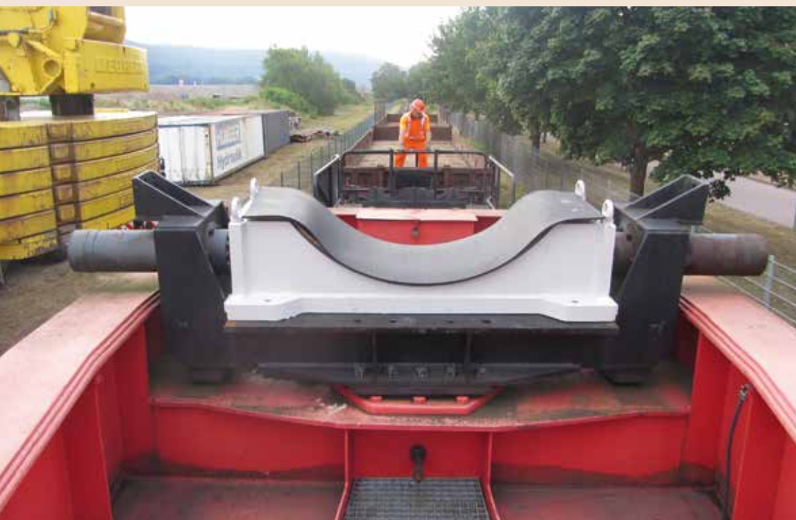
Vorbereitungsarbeiten am Schienentiefadewagen: Die Verschubträger werden entsprechend positioniert und die Lastträger angebracht.
