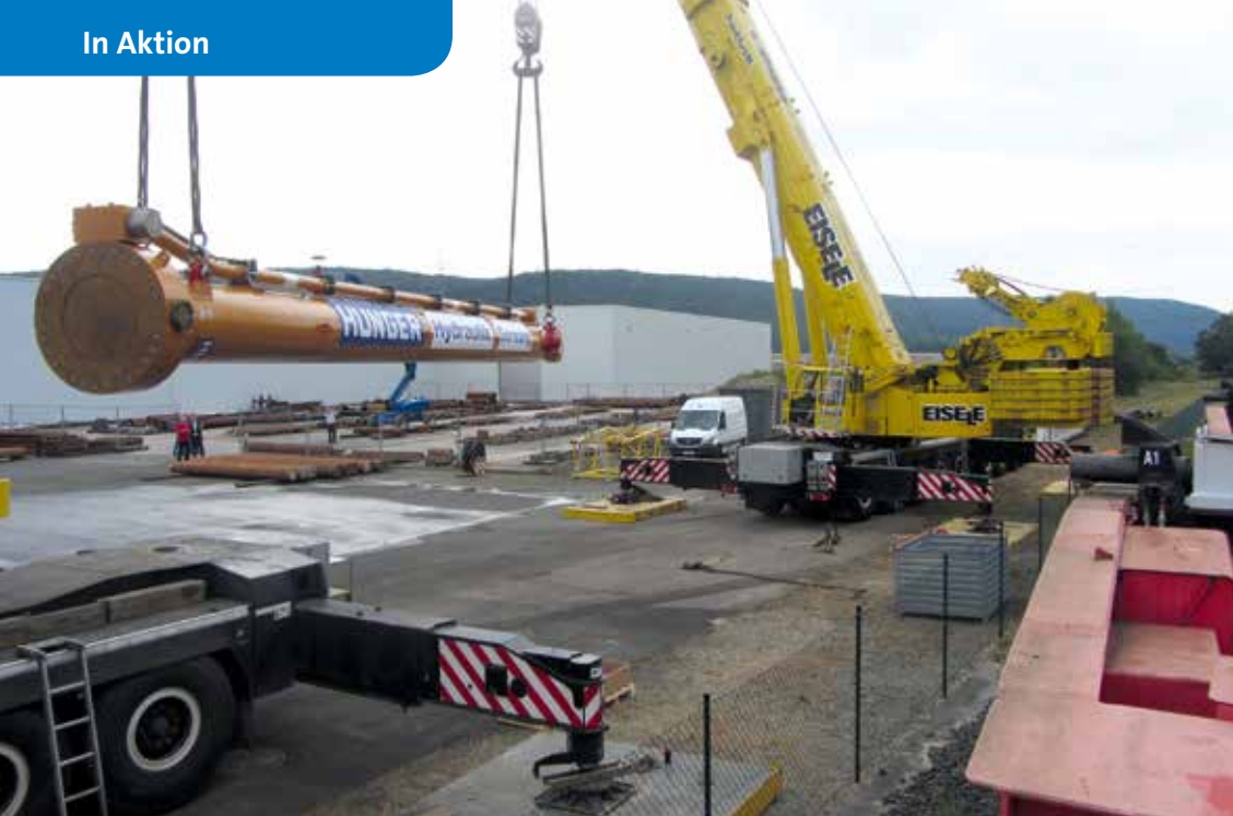
Im Tandem schlagen zwei 500-Tonner von Eisele das Ladegut auf das bereitstehende Schienenfahrzeug um.
