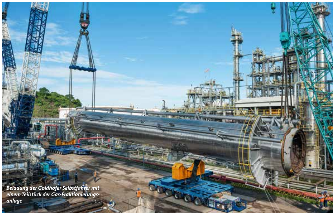
Ein 515 t schwerer Kohlendioxid-Absorber wird vom Hafen auf das neue Werksgelände in Palembang transportiert.
