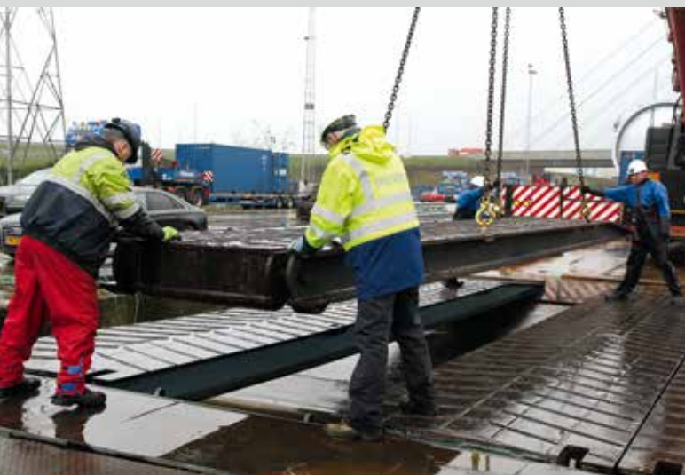
Am folgenden Morgen half ein Teleskopkran von Mammoet dabei, die Rampen an die Barge zu legen.
