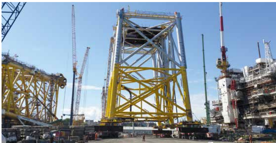
Ein Stützelement der Förderplattform auf Scheuerle SPMT.
