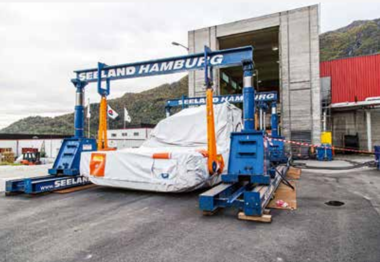
Einbringen der Turbine mit eigenem Gerät und Personal.
