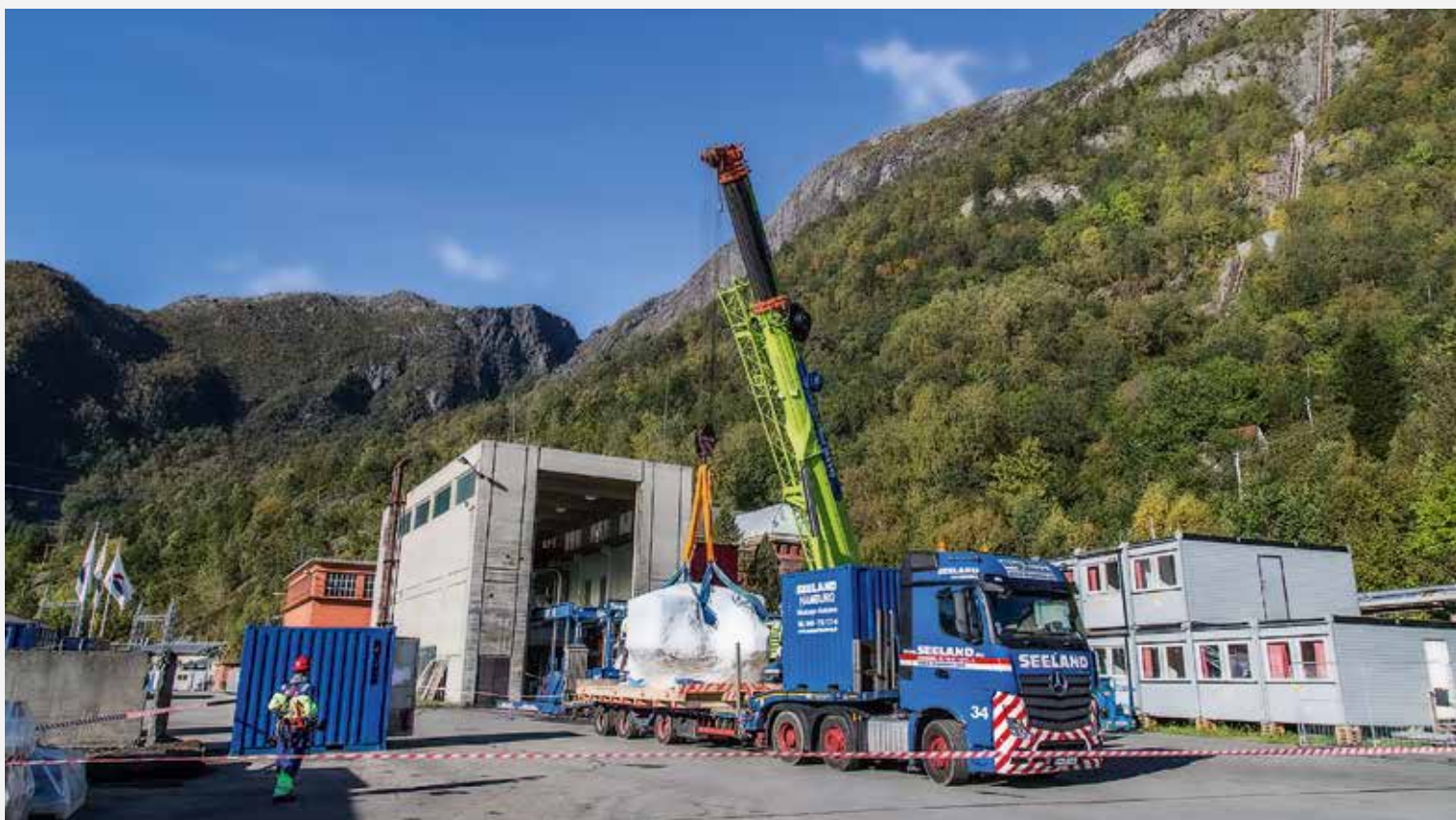
Seeland transportiert eine 105 t schwere Turbine von Hamburg nach Norwegen bis auf die Endposition im Kraftwerk.
