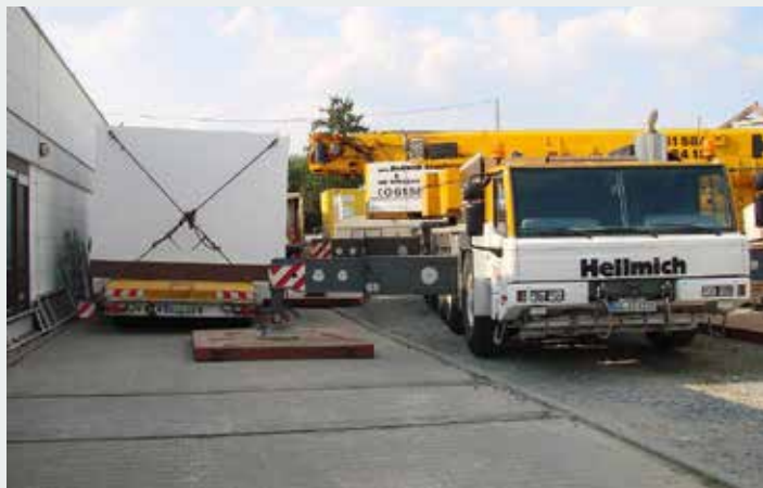
Die Be- und Entladung wurde jeweils mit einem 130 t-Kran durchgeführt.
