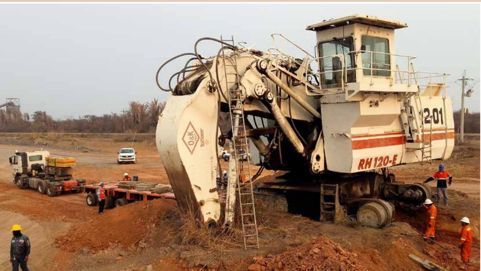
Aufgewühlt: Nachdem die Erde unter dem Bagger abgegraben worden war, konnte der Goldhofer THP / SL12 unter den Minenbagger manövriert werden.
