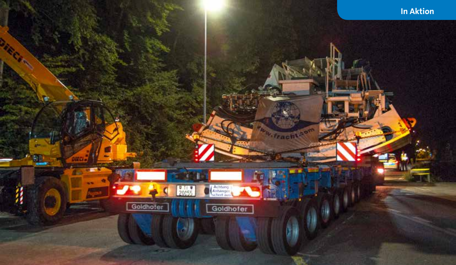
Rückwärts ging es in die Baustelle, das Schildsegment wog 105 t.
