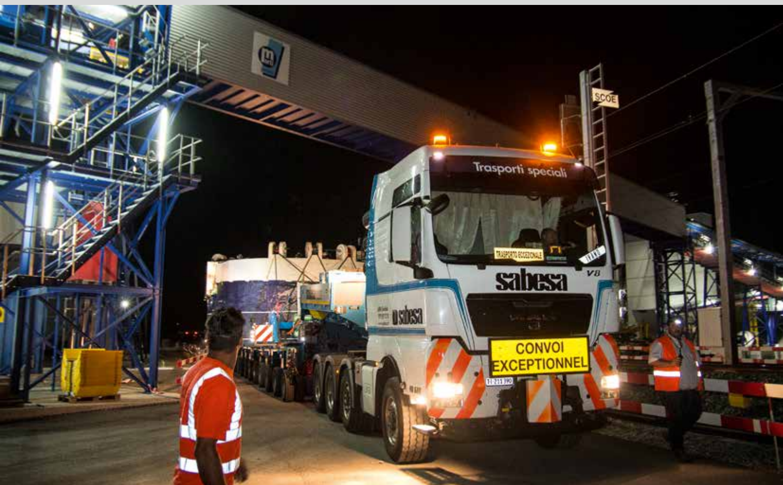
Der Schwertransport fährt auf der Baustellenstraße unter dem Förderband durch, das später den Tunnelausbruch ins Kieswerk transportiert.
