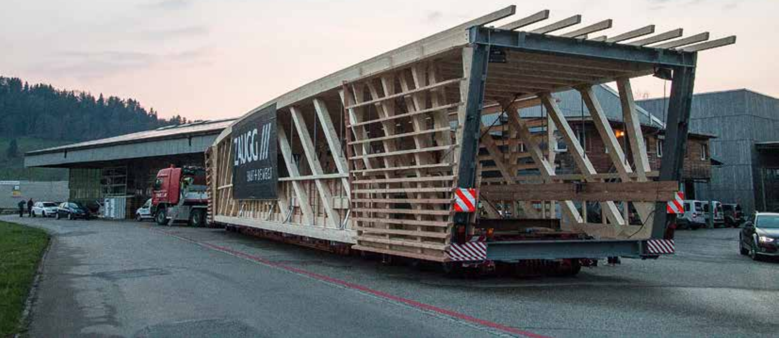
Letzte Vorbereitungen vor der Abfahrt. Die Brücke weist eine Kurve auf, wodurch sie breiter wird.
