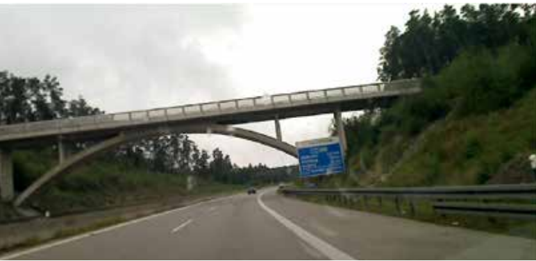
Vermessung einer Autobahnbrücke während der Fahrt.
