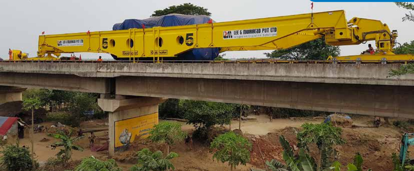
Auf der Transportstrecke mussten viele Brücken überfahren werden.
