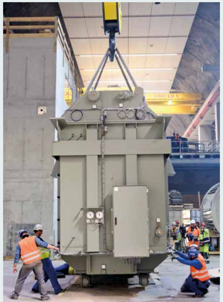
Die Bau-Trans-Abteilung Montagelogistik realisierte die Fundamentstellung.
