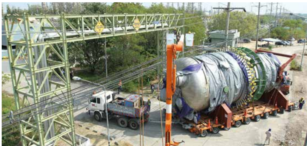
Ein 227 t schwerer Reaktor unterquert auf THP-Achslinien eine Stromleitung.
