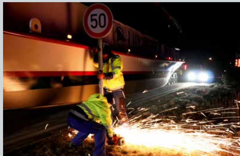
Wo Schilder im Weg standen, wurde zum Trennschleifer gegriffen.
