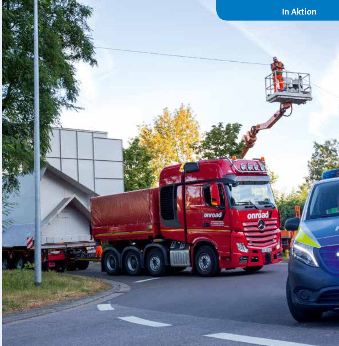
Diverse Versorgungsleitungen mussten angehoben werden.
