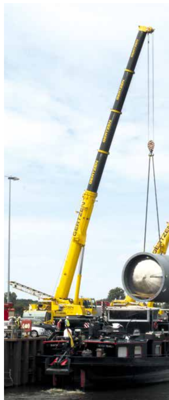
In Haren wurden die Behälter im Tandemhub auf Binnenschiffe umgeladen.
