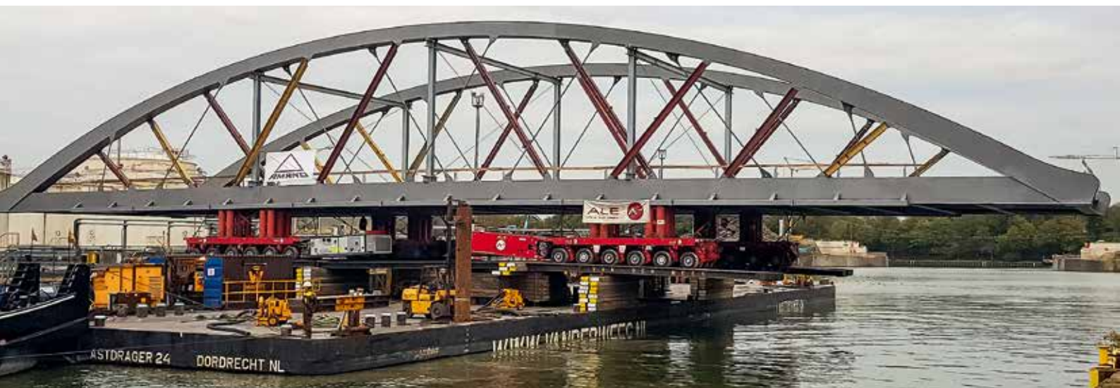
Fahrt mit Überhang. An beiden Seiten ragten die Fahrbrücken über die Pontons hinaus.
