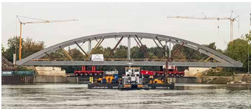
Einschwimmen der Brücke.
