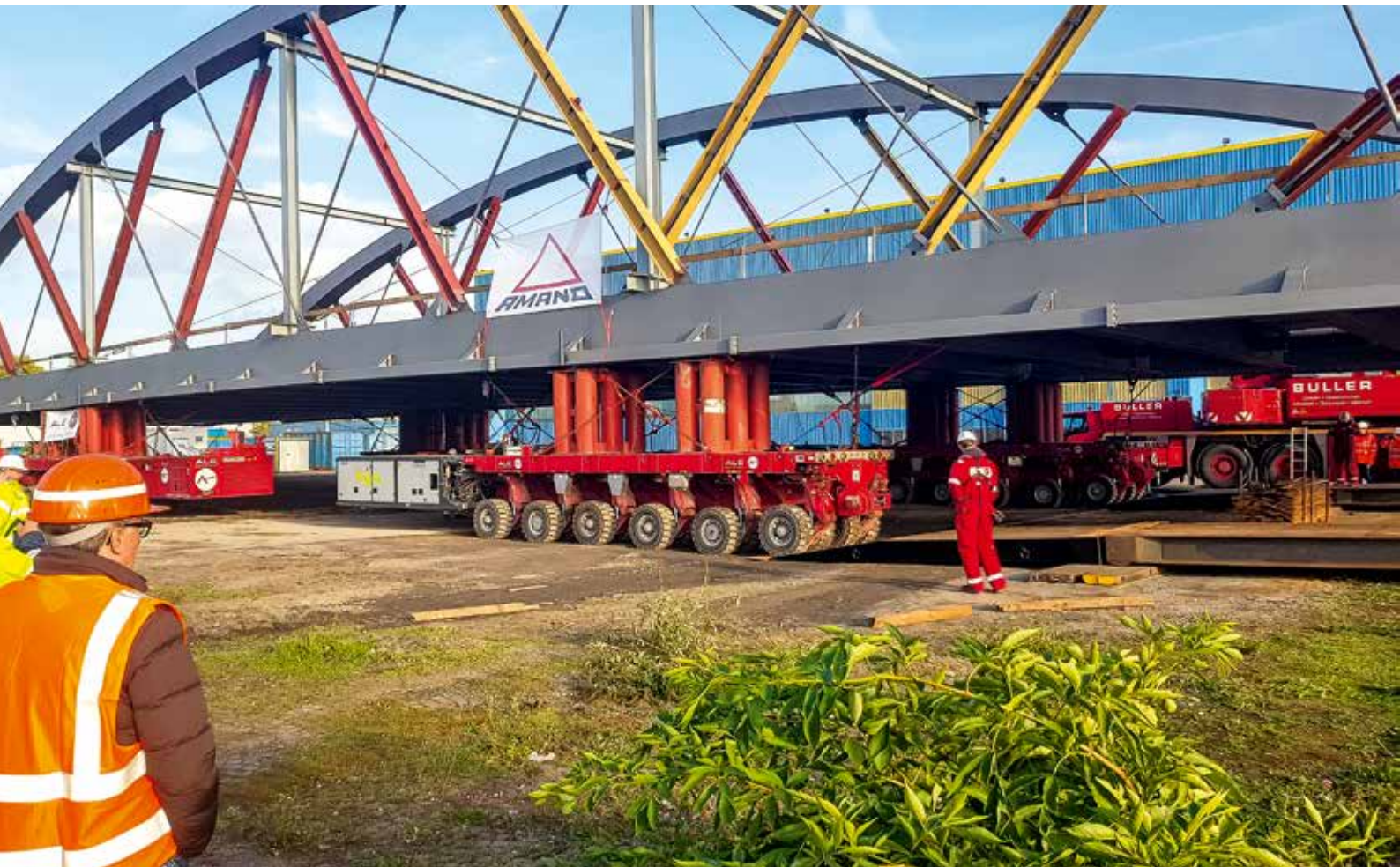
Auffahrt auf die Rampe zur Behelfsbrücke.
