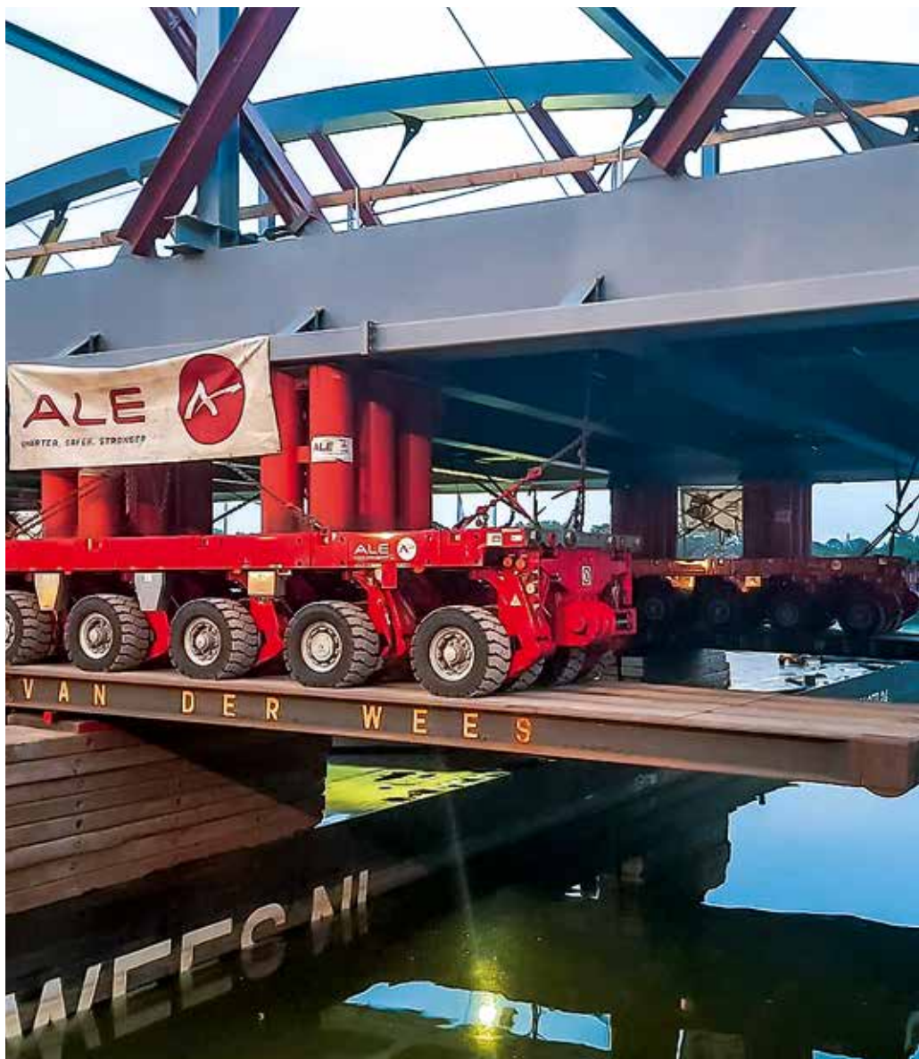
Aufgeschichtet: auf den Potons wurden Hölzer geschichtet, auf denen die Fahrbrücke ruht. Darauf sind die Selbstfahrer mit Elefantenfüßen und Brücken positioniert.
