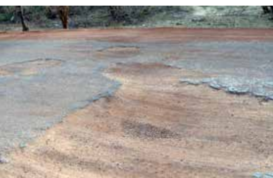
Das Bild dokumentiert den schlechten Zustand der Straßen. Dennoch musste wegen der Gefahr von Anschlägen mit teils nicht hohen Geschwindigkeiten gefahren werden. Das führte zu hochfrequenten und -dynamischen Belastungen.
