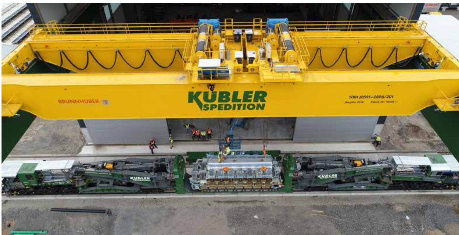
Der mächtige 500 t Brückenkran lädt einen 300 t schweren Transformator um. Der Weitertransport erfolgt mit einem Schienentiefladewagen mit Tragschnabelausrüstung von Kübler.
