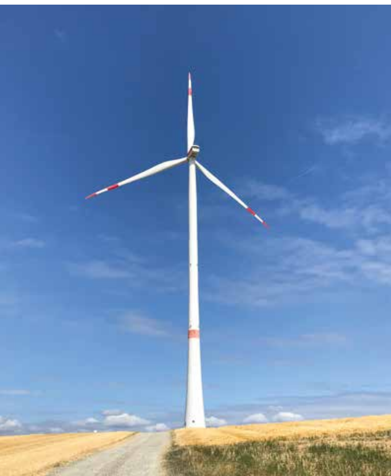
Gerade einmal 86 WEA wurden in Deutschland im ersten Halbjahr 2019 installiert. STM-Bild
