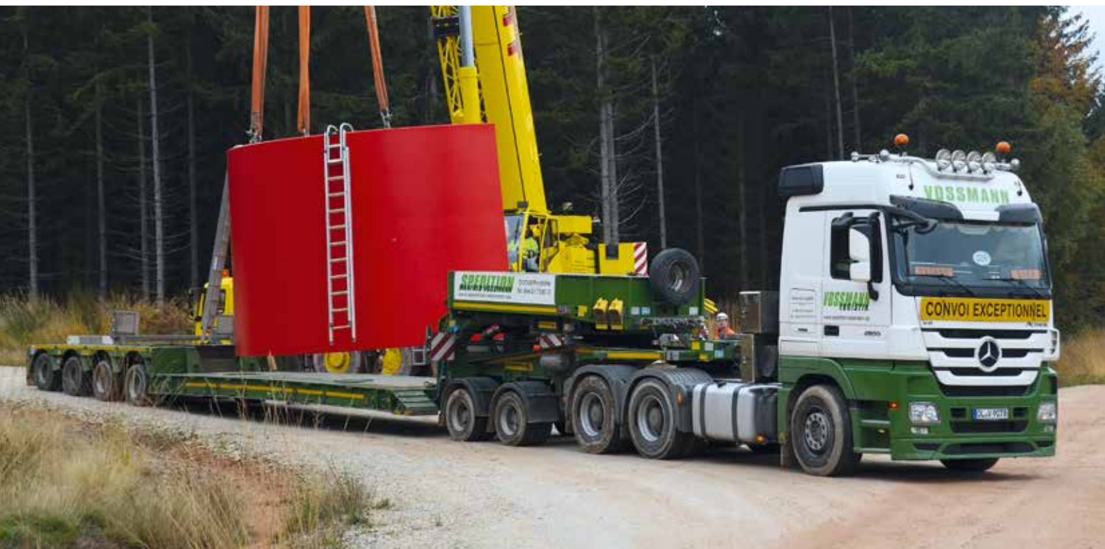
Betonturmteil einer WEA wird entladen.
