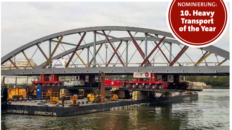
An beiden Seiten ragt nicht nur die neue Hafenumrundbrücke über den Ponton hinaus, sondern darunter auch die Fahrrampen mit den Selbstfahrern. Foto: Michael Bergmann
