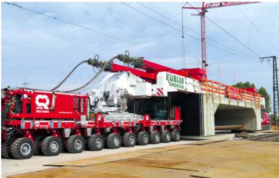
Der erste Transport steht abfahrbereit am Vormontageort und wartet auf die Freigabe zur Fahrt über ausgelegte Gleise zum Einbauort.
