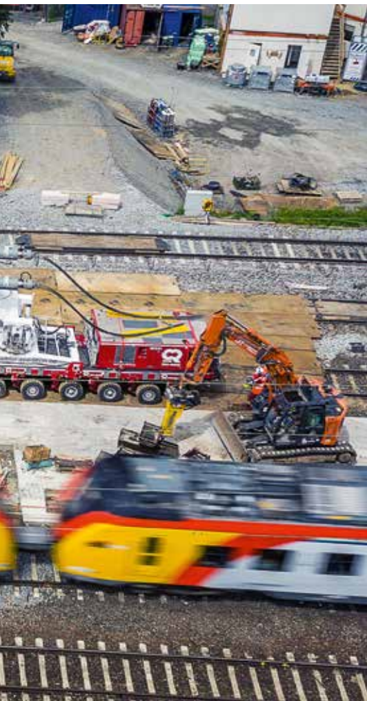
Der erste Transport steht abfahrbereit am Vormontageort und wartet auf die Freigabe zur Fahrt über ausgelegte Gleise zum Einbauort.
