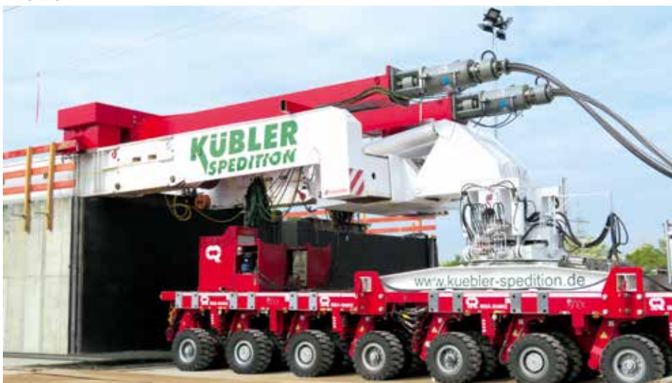
Das erste Segment wird aufgenommen. Über Litzenheber wird die Last angehoben und später abgesenkt.
