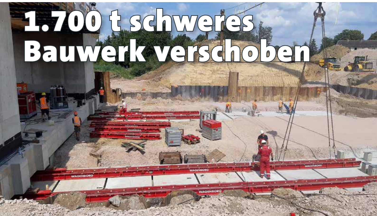
Die Schienen des Verschubsystems werden ausgelegt.
