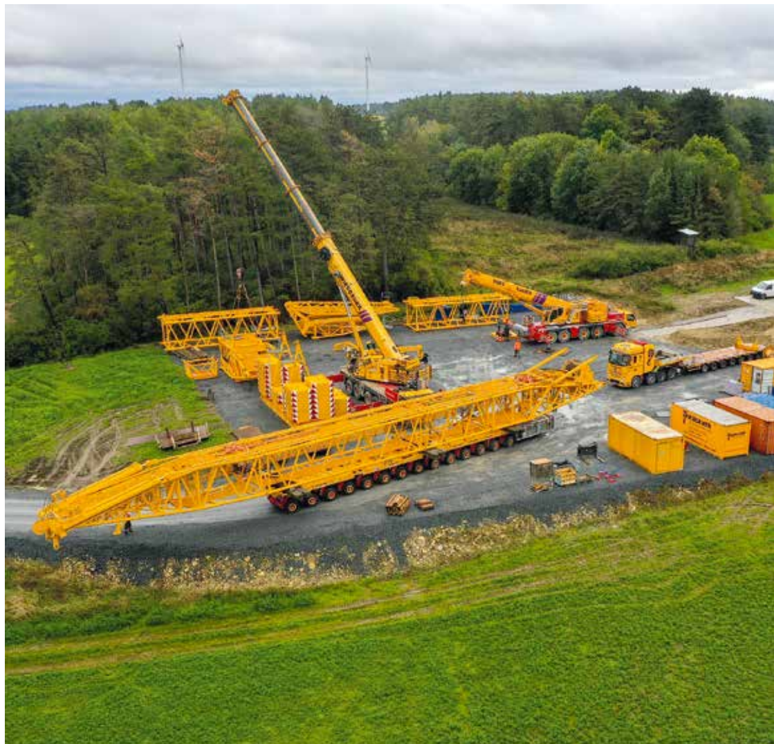
Abbau des Liebherr LR11000 Raupengitterkrans der Firma Wiesbauer.
