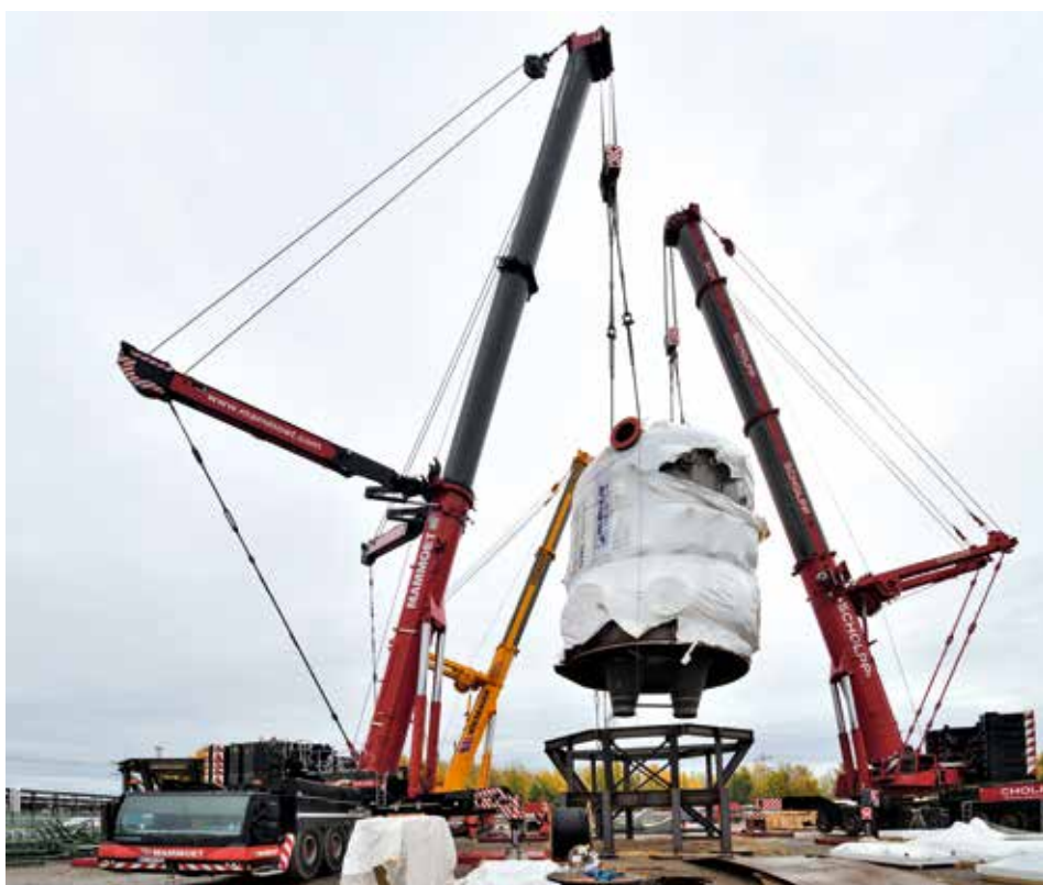
Dreikranhub zum Aufstellen des Reaktorkopfes auf dem Vormontagegestell.
