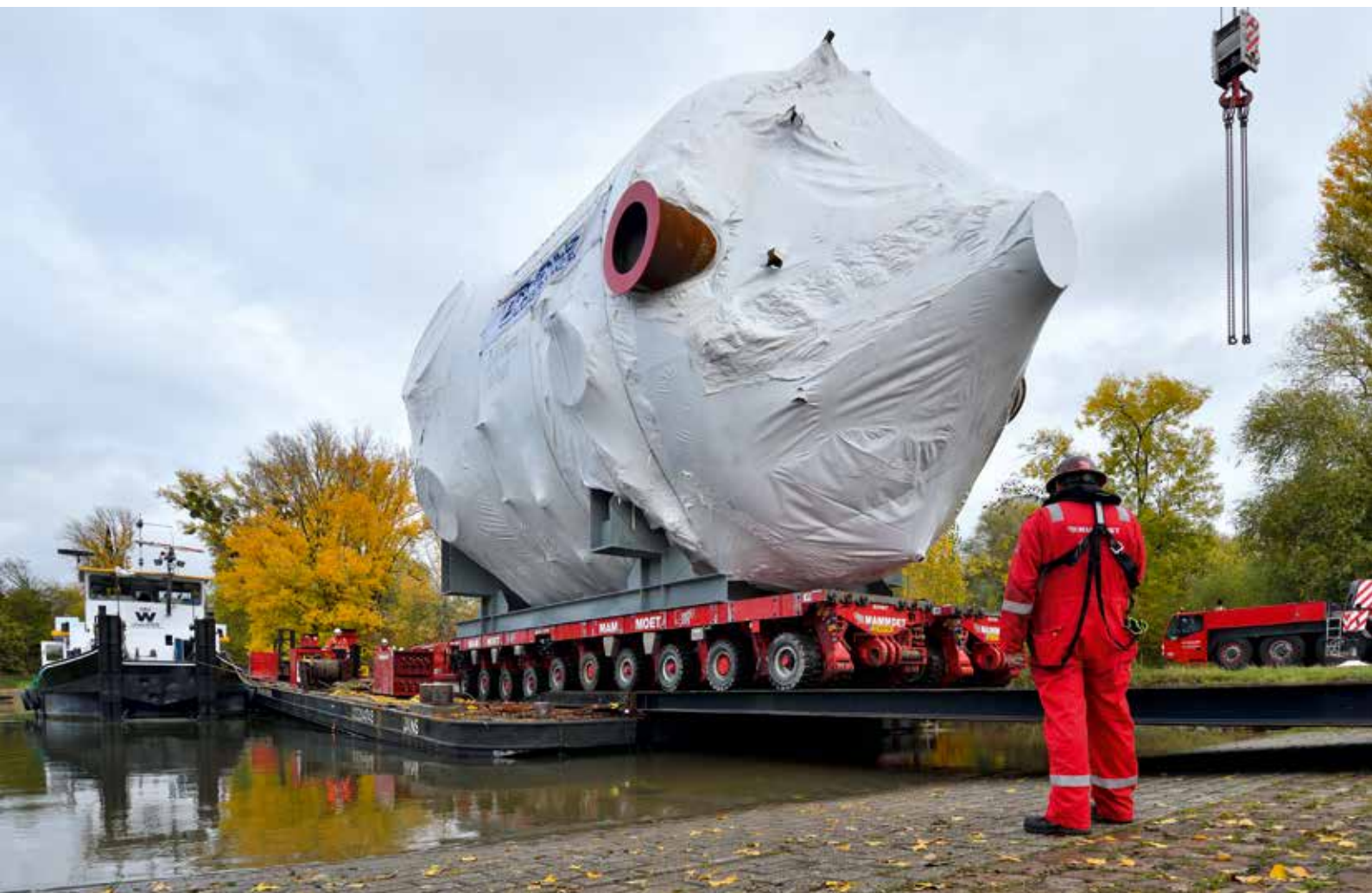
RoRo-Entladung des FCC-Reaktorkopfes.
