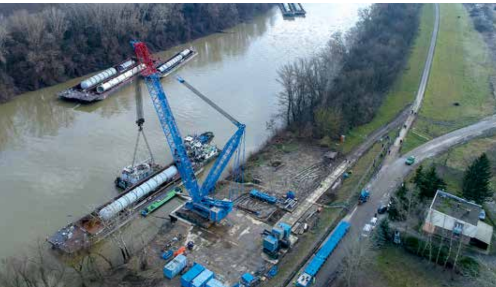
Der Umschlagplatz an der Theiß wurde speziell für den Auftrag errichtet.
