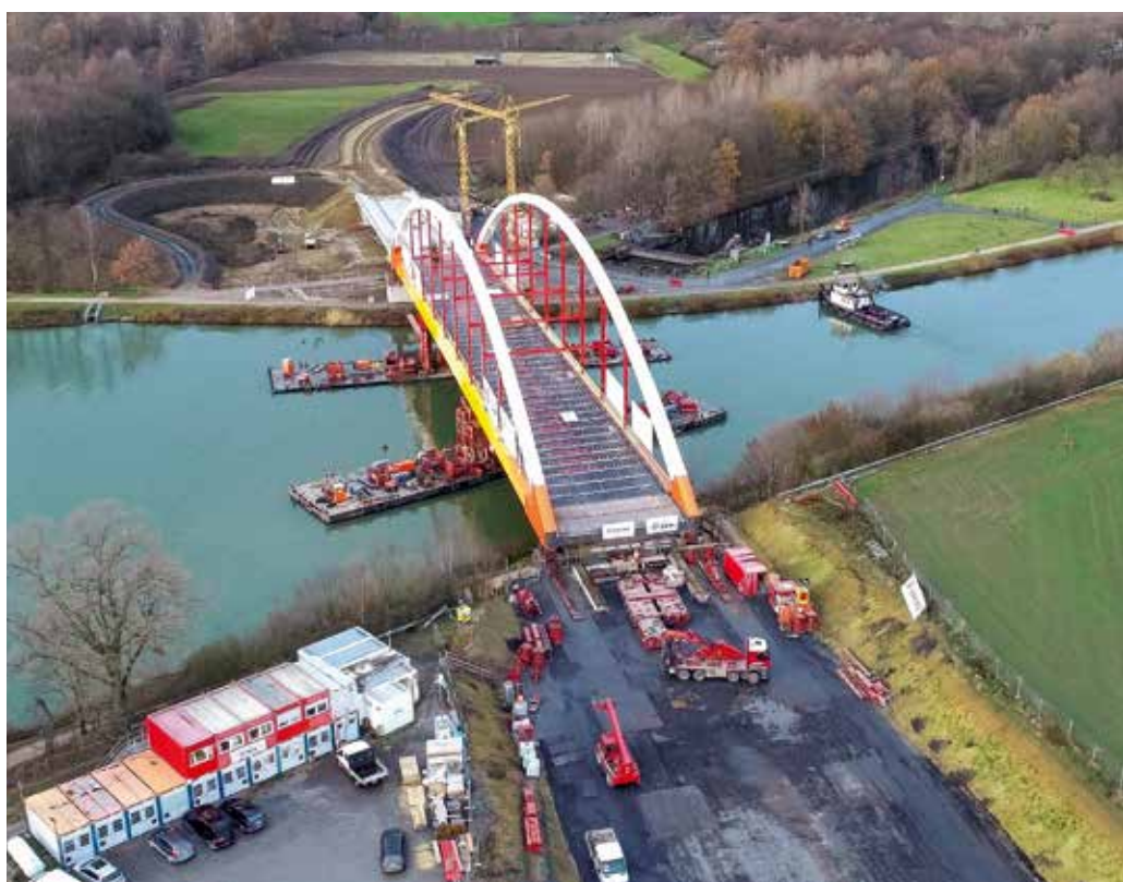
Mit Hilfe der SPMTs wird die neue Stabbogenbrücke auf die Schwimmpontons geschoben.
