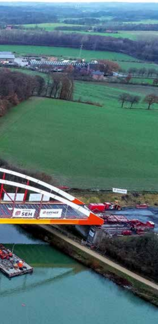
Zwei Schwimmpontons schwammen die Brücke millimetergenau ein.
