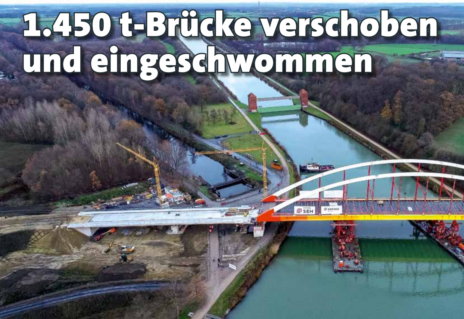
Neue Stabbogenbrücke über den Dortmund-Ems-Kanal.
