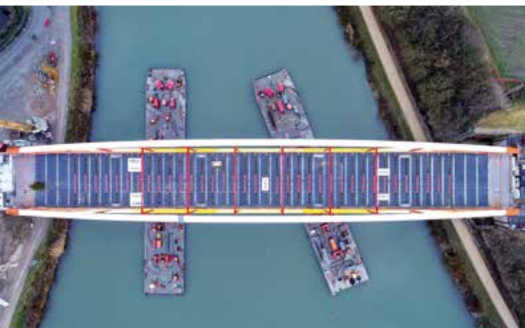
Die Brücke wird später einmal zwei Fahrspuren sowie einen separat geführten Geh- und Radweg haben.
