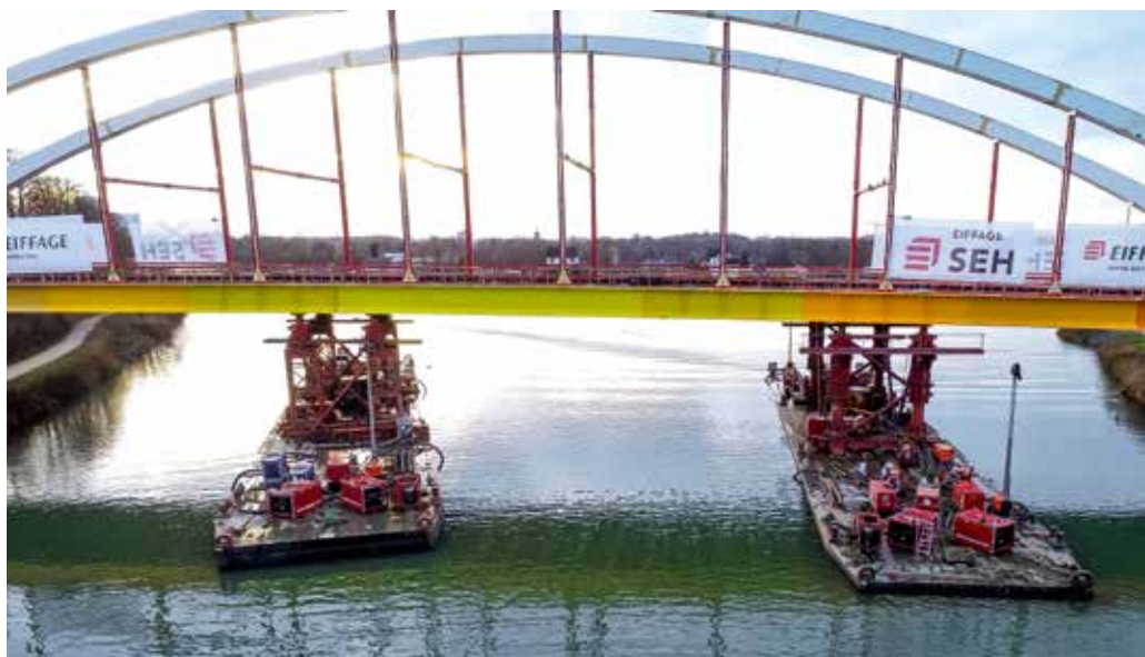
Zwei Schwimmpontons schwammen die Brücke millimetergenau ein.
