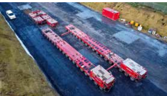
Mit Hilfe der SPMTs wird die neue Stabbogenbrücke auf die Schwimmpontons geschoben.
