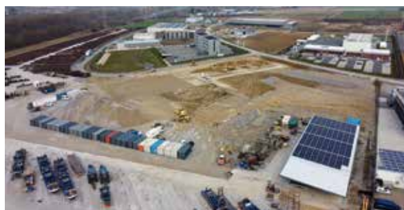
Hier entsteht die 8.000 m 2 große Lager- und Logistikhalle.
