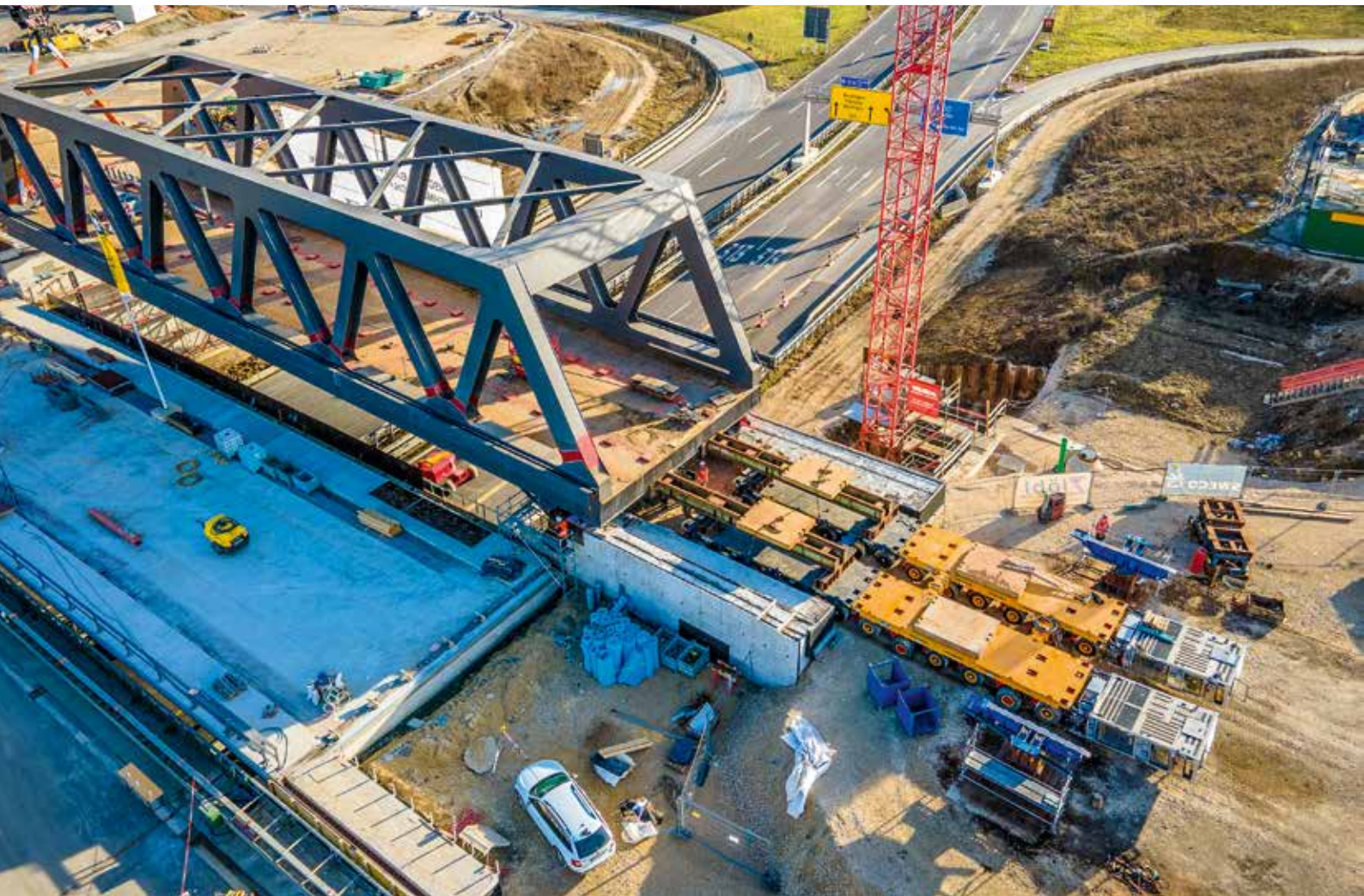
Während die Cometto SPMT Selbstfahrer mit den montierten Rahmen die Brücke verschoben ...
