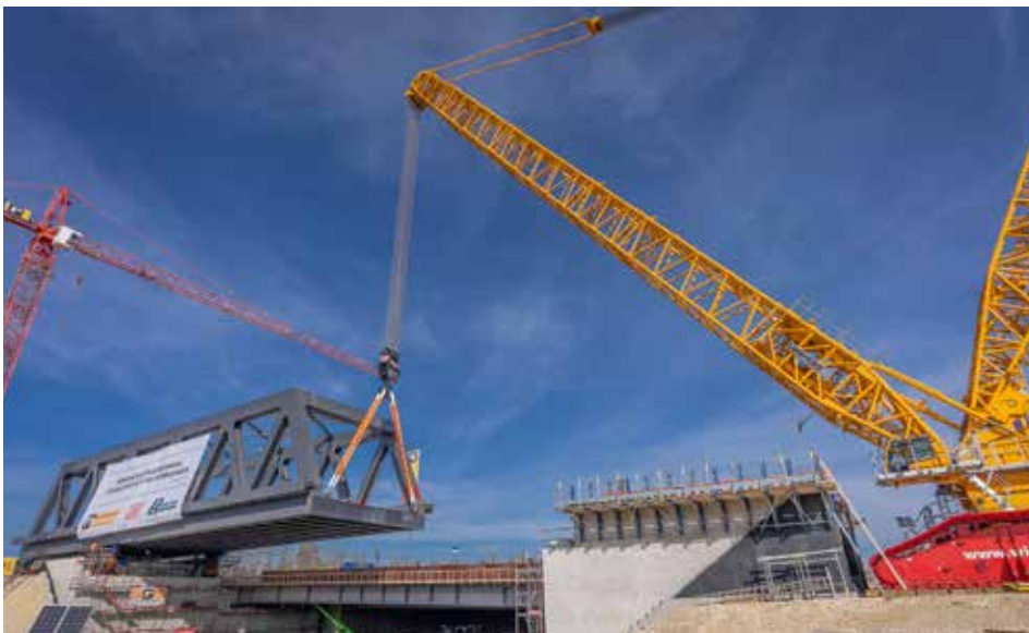
... übernahm ein 1.000 Tonnen Raupenkran die Brücke auf der anderen Seite. Perfekte Koordination zwischen Kran und SPMTs war gefragt.
